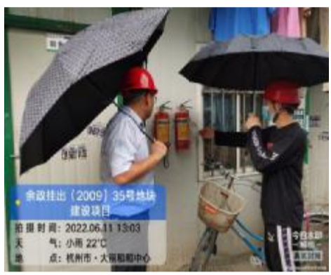
余政挂出[2009]35号地块项目部开展消防安全检查
