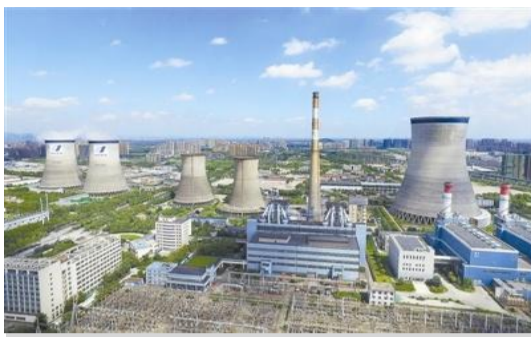
▲拆除前的半山电厂冷却塔
