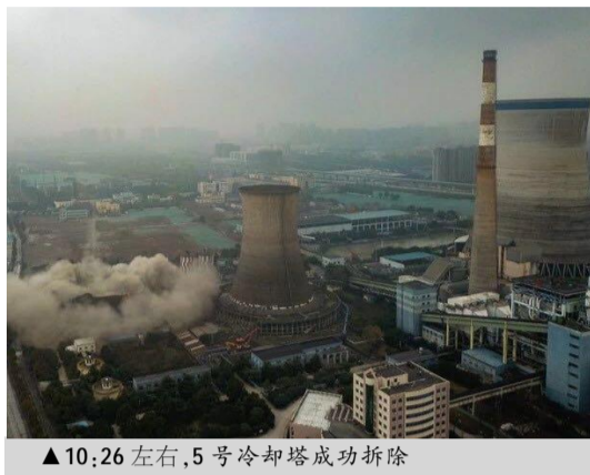
▲10:26左右,5号冷却塔成功拆除
